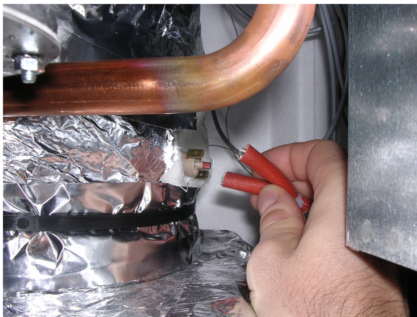
Figuur 2 – Inspectie van de limietthermostaat van de generator
